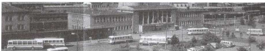
Obr. 10: Stávající autobusové nádraží Žďár nad Sázavou nedlouho po zahájení provozu
